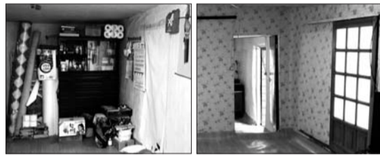
공사 전 공사 후 성민종합건설이 50cm 턱을 넘어 다니야 하는 할머니를 위해 나무계단을 설치하고 장판도 깔아 편히 다닐 수 있도록 만들었다.
